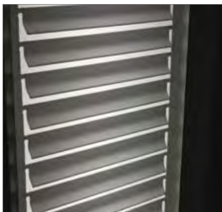
Particolare del louver Louver detail
